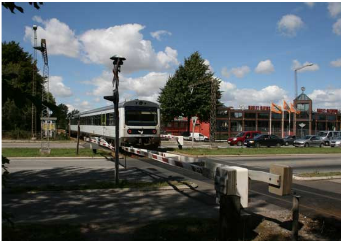
Tog ved Grenåvej
